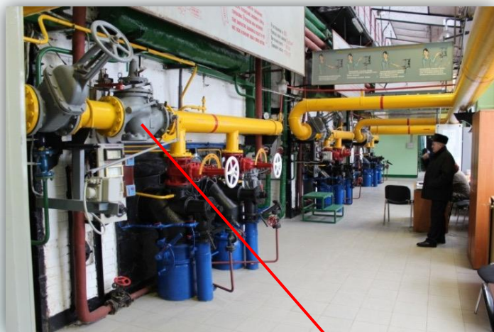
Реконструируемое газовое оборудование
